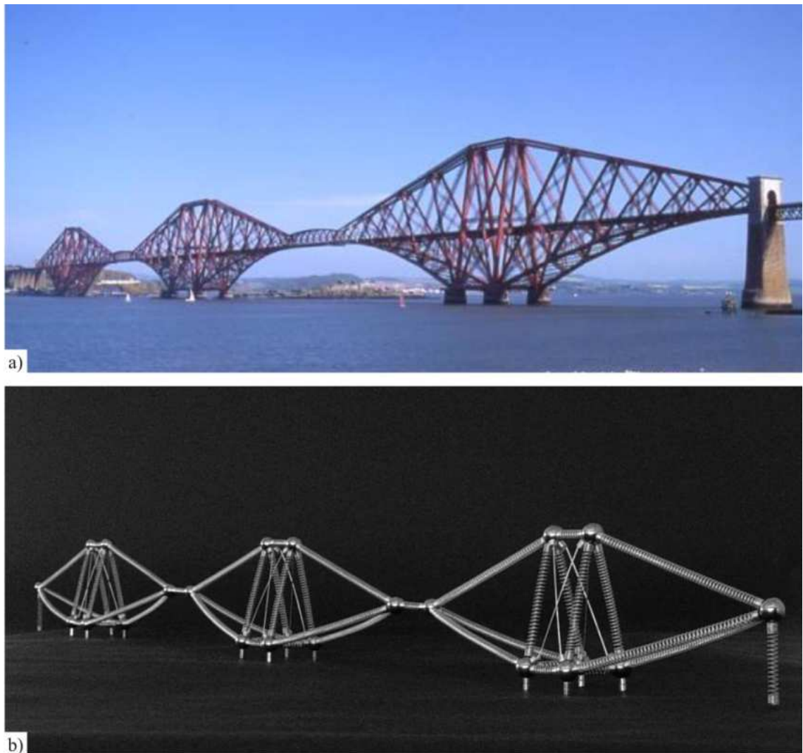
Figura 7.7 - Forth Railway Bridge representada com a Maquete Estrutural
